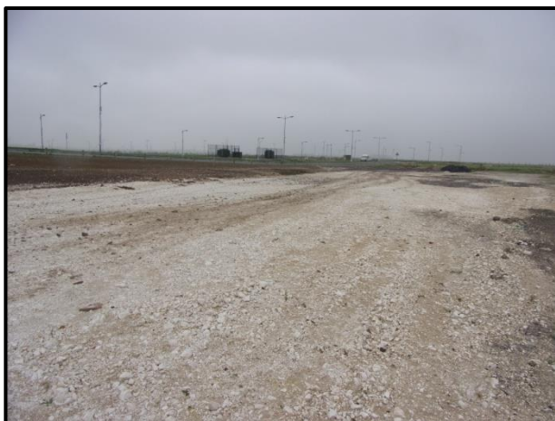
Photo 14: zone de travaux (Rainette, 2018)
